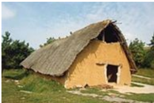
Reconstitution d'une maison danubienne dans le Domaine de Samara, La Chaussée-Tirancourt (Somme). Les murs en bois sont recouverts de torchis et le toit est en chaume.
