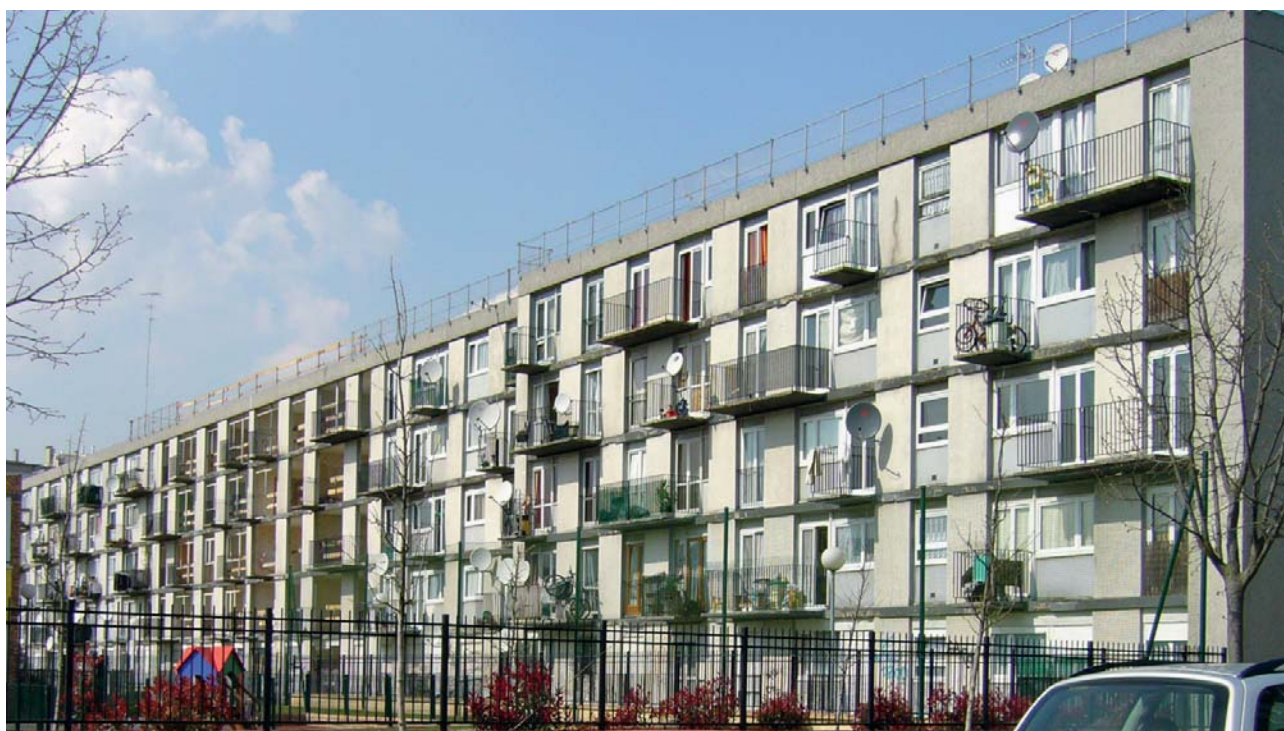
Vue du bâtiment d'origine : la façade sud s'ouvre vers le groupe scolaire.
