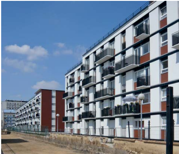
Le pignon a été retraité. Les menuiseries fines des garde-corps ont été conservées ; cependant un filtre a été ajouté afin de protéger le balcon des regards.
