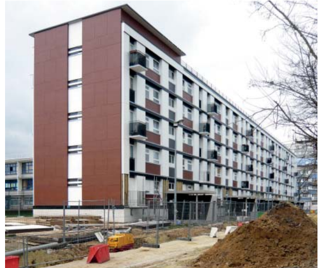
Vue façade nord avec les extensions des halls en construction.
