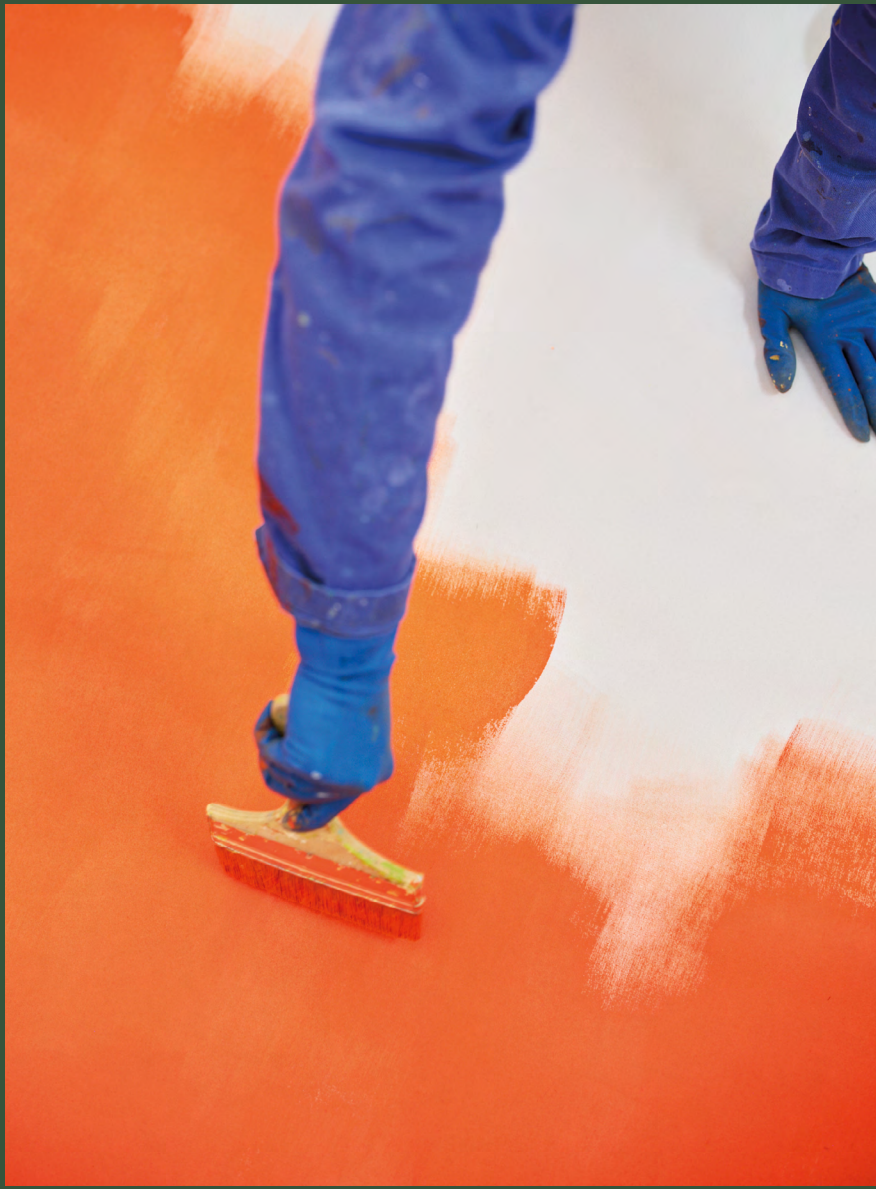
← Travail en cours à l'atelier : le choix des couleurs est inspiré du vermillon d'origine de la Maison du Peuple
