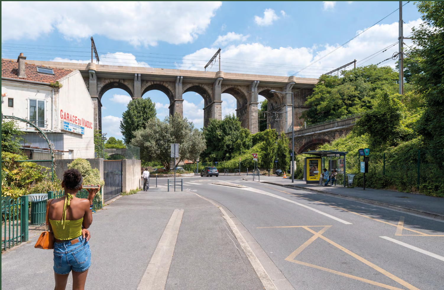
↓ Viaduc de Meudon
