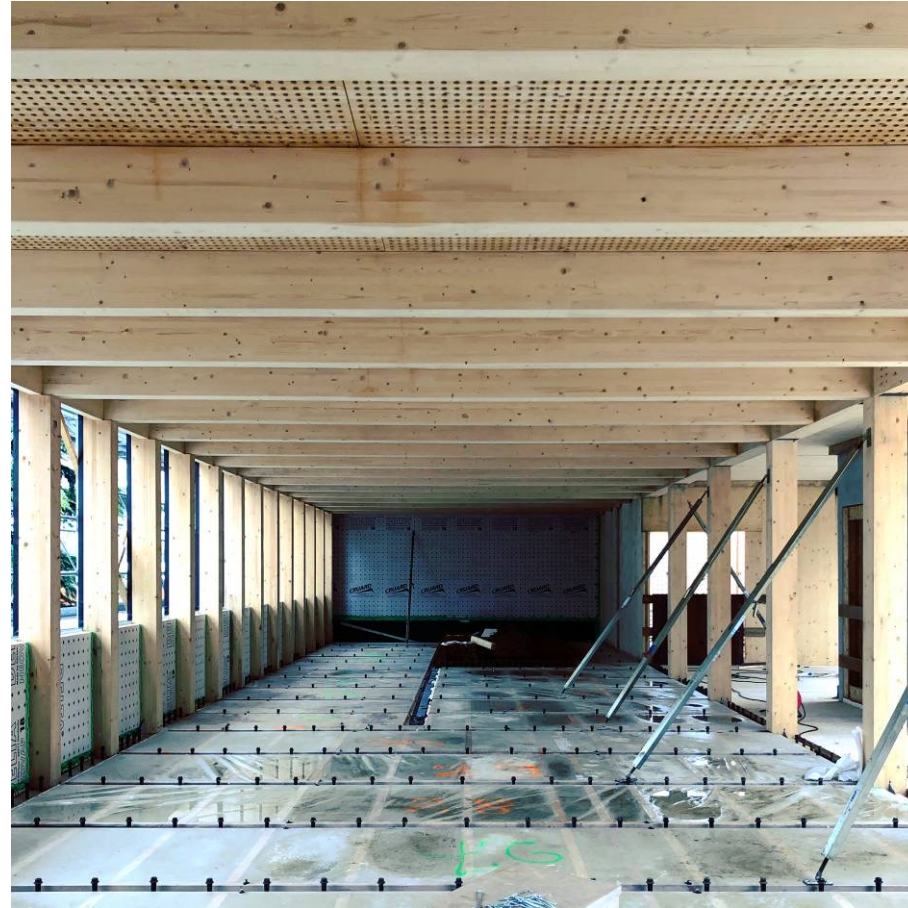
320 m3 de bois soit une structure 5 fois moins lourde qu'un équivalent béton.
