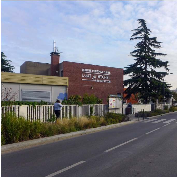
L'ancien pignon de briques du CSC.
