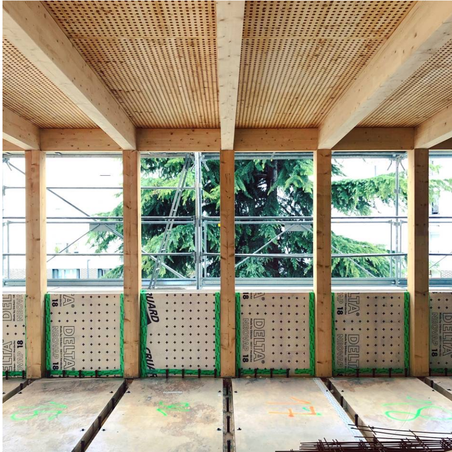
Photos de chantier. Système poteaux-poutres bois connectées et caissons préfabriqués.
