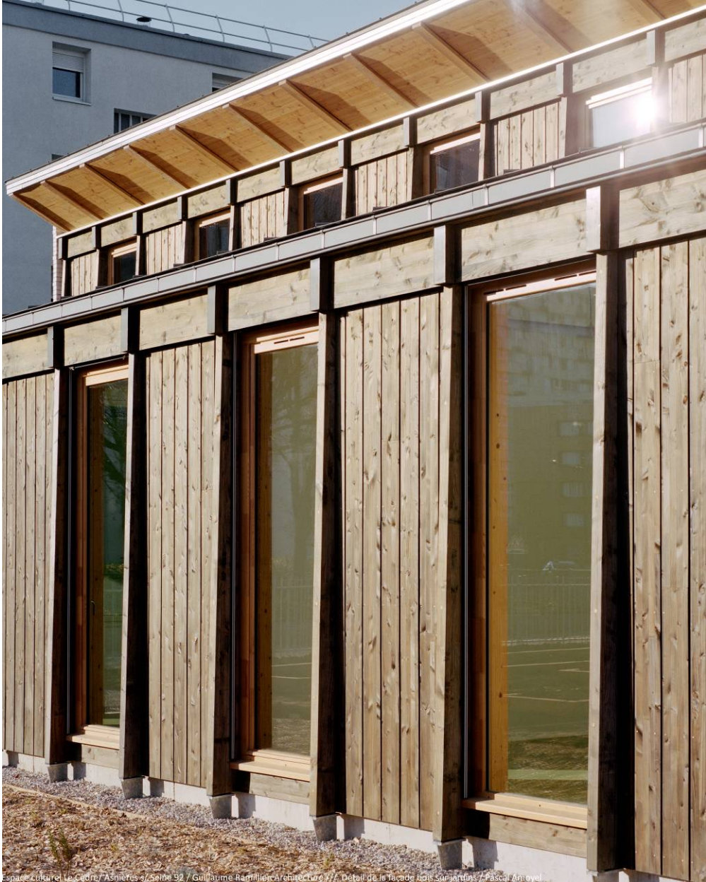
Espace culturel Le Cèdre / Asnières s/Seine 92 / Guillaume Ramillien Architecture /// Détail de la façade bois sur jardins / Pascal Amoyel
