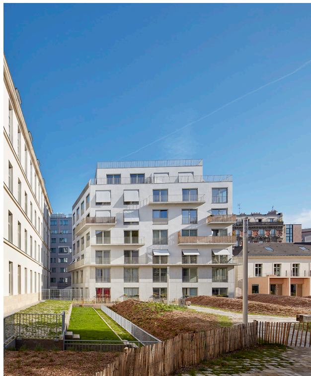
Lot C construction neuve et réhabilitation lourde 127 logements familiaux + 7 ateliers d'artistes+ local d'activités+ cabinet médical NP2F/Office KGDVS - Urbaine de travaux
