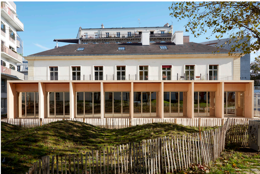
Lots D-E réhabilitation de 2 pavillons et extensions pour accueil + commerces + local d'activités ou bureaux Mir - GTM
