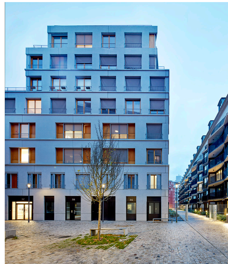
Lot F construction neuve de 2 bâtiments R+7 79 logements + une crèche de 66 berceaux + locaux commerciaux Lacroix Chessex - Sicra
