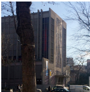
Image n°3 Eglise Saint Jacques le Majeur Arch. Eric Bagge 1934 - 1940
